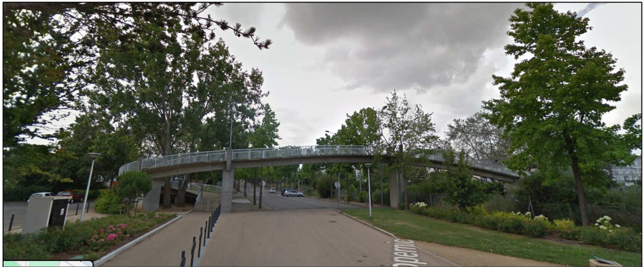
Vue de la passerelle
